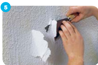
5 Удалить отслаивающийся слой краски, хорошо держащуюся краску вымыть.
